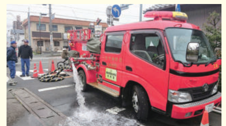
消火用井戸を点検中です
